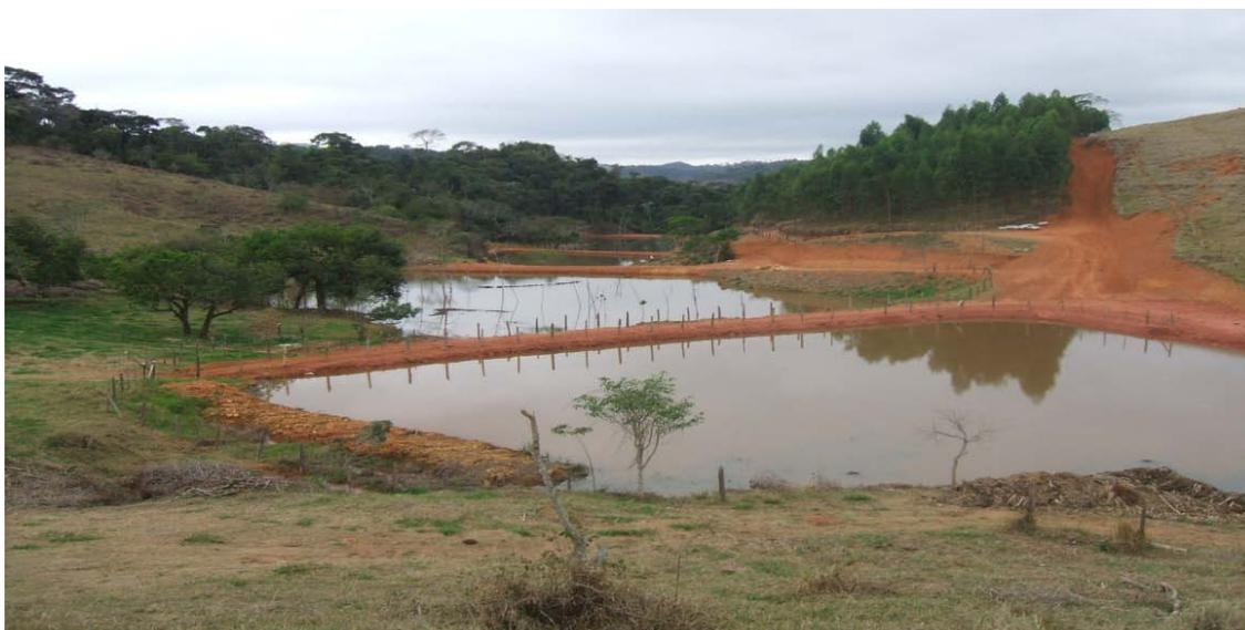
**Figura 21.** Construção de açudes visando a recarga de aquíferos no IF Sudeste de Minas campus Rio Pomba.
