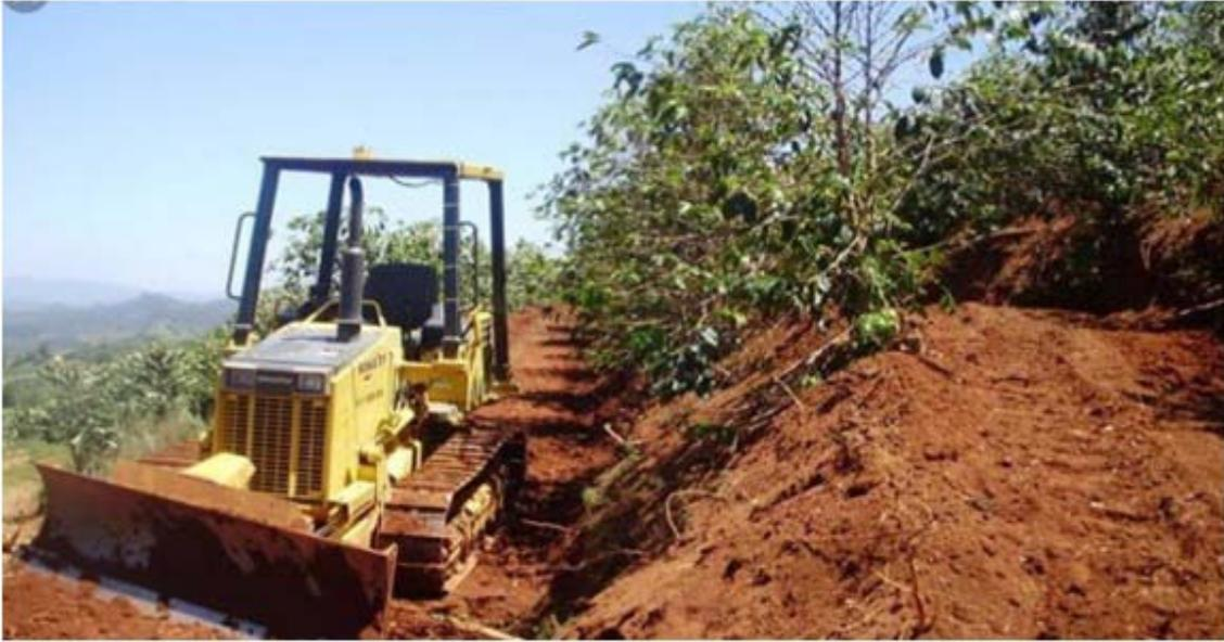
**Figura 18.** Construção de microterraceamento em uma lavoura cafeeira. Fonte: CAFEPOINT, 2020.
