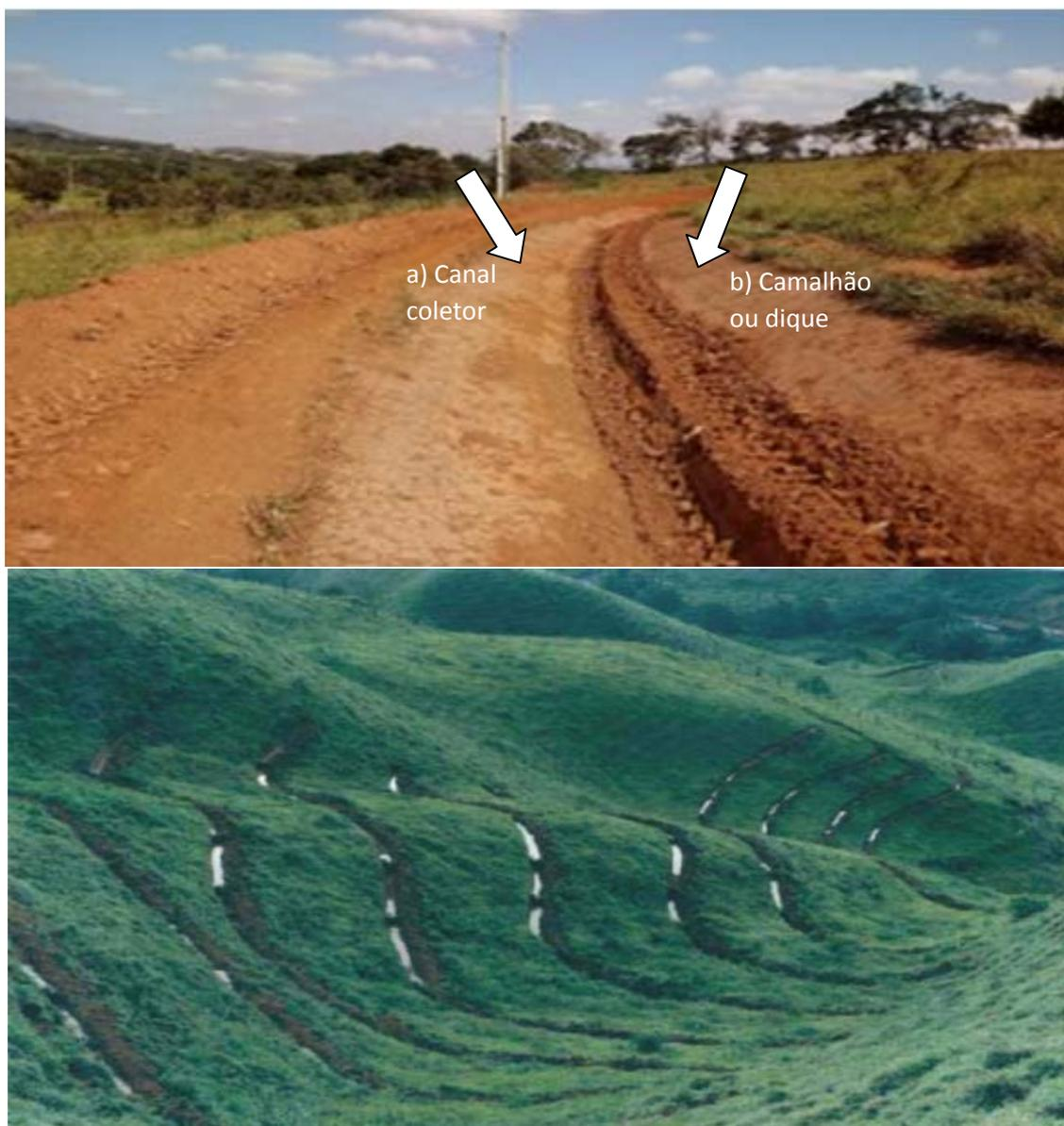
**Figura 13.** Acima. Construção de um terraço. Fonte: Adaptado pelos autores da Secretaria de Agricultura de Minas Gerais, 2020. Abaixo. Terraços de base estreita com acúmulo de água.
