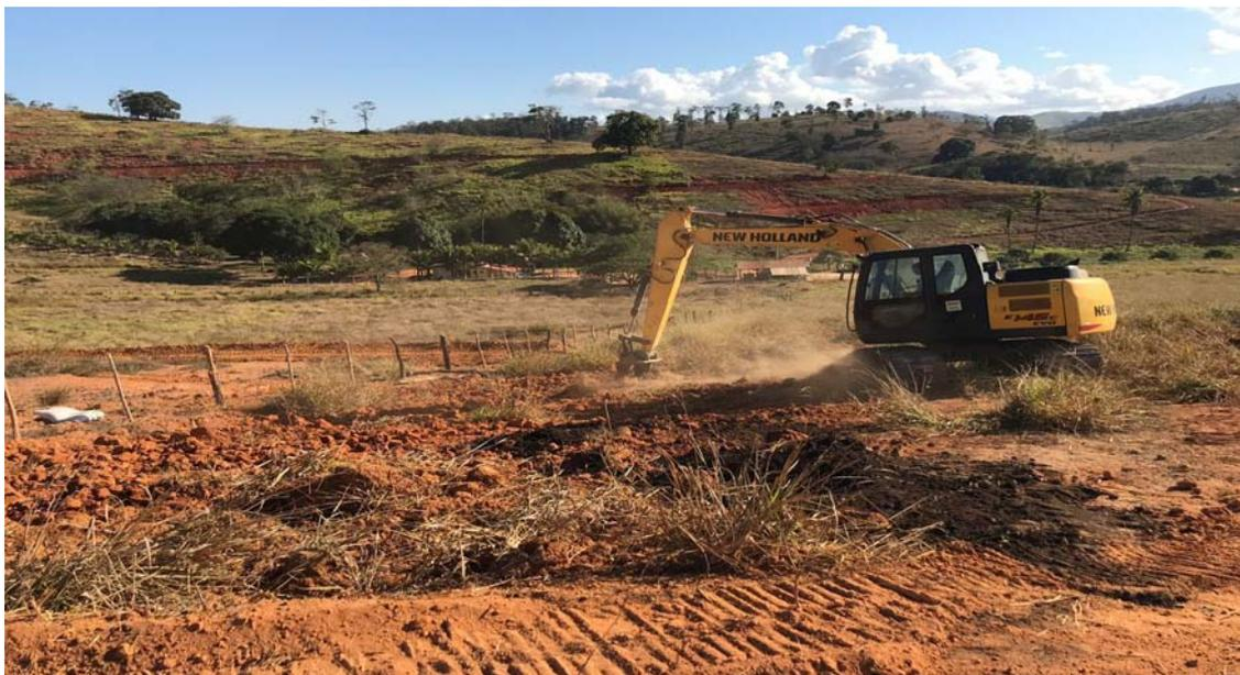
**Figura 22.** Retroescavadeira realizando escarificação e recomposição topográfica.
