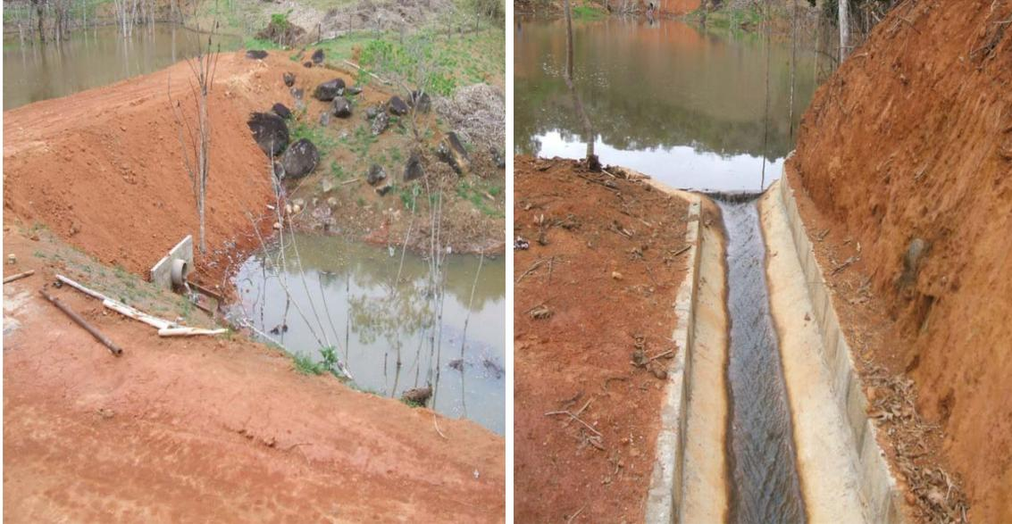
**Figuras 17 e 18.** Revegetação de taludes e valeta de drenagem (ladrão) de represa da área da invernoada do IF Sudeste de Minas campus Rio Pomba.
