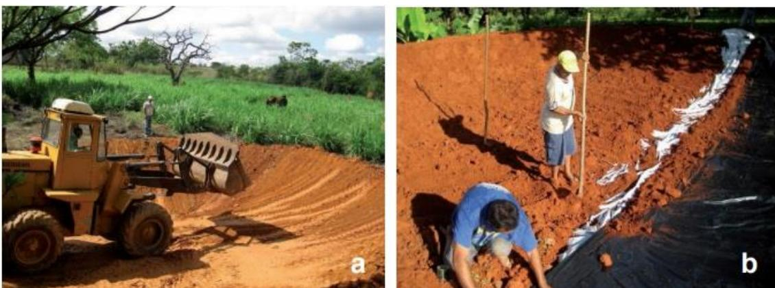
**Figura 12.** Escavação para construção do lago de múltiplo uso (a) e colagem da lona e cobertura com terra (b). Fonte: Barros et al. (2013).
