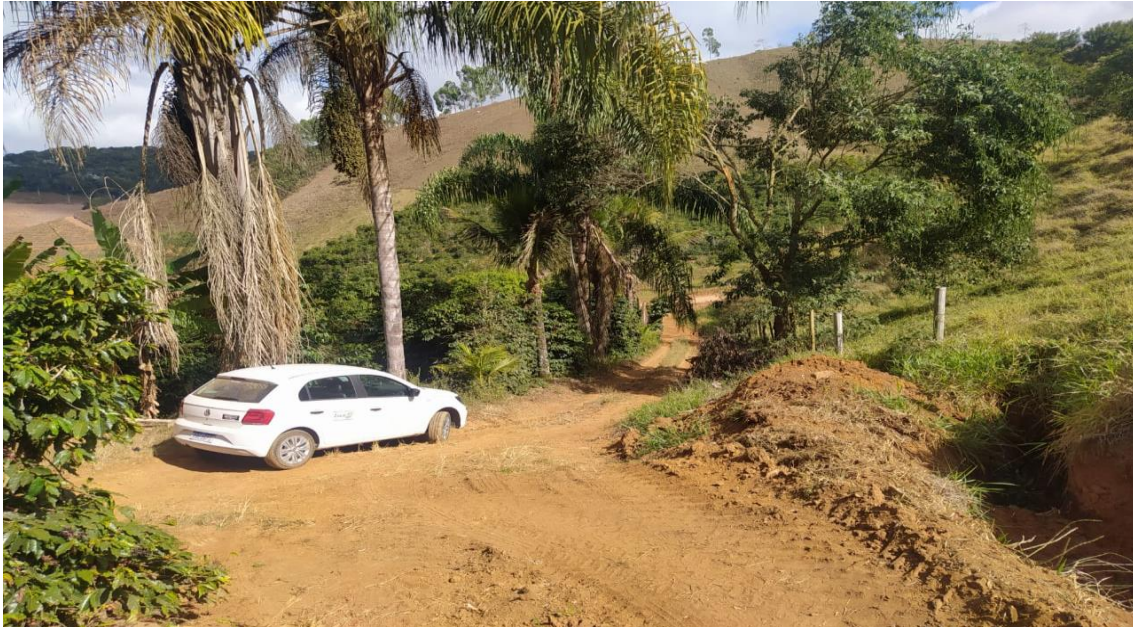
Figura 8. Caixa seca ou barraginha na margem de uma estrada. Fonte: Acervo Priscila de Oliveira Nascimento (2022).
