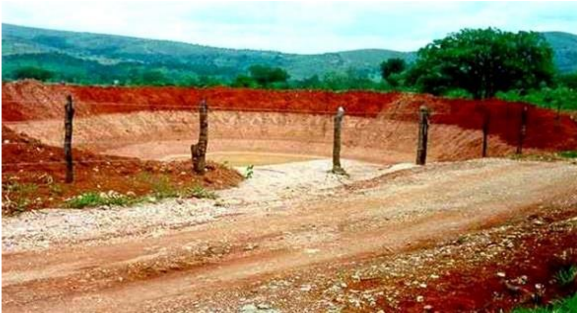
Figura 10. Infiltração e recarga de barraginha em beira de estrada. Fonte: Embrapa (2018).
