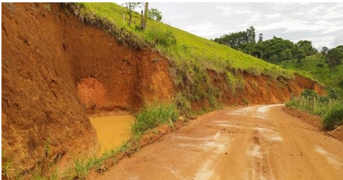
Figura 7. Caixa seca ou barraginha na margem de uma estrada. Fonte: Acervo Priscila de Oliveira Nascimento (2022).
