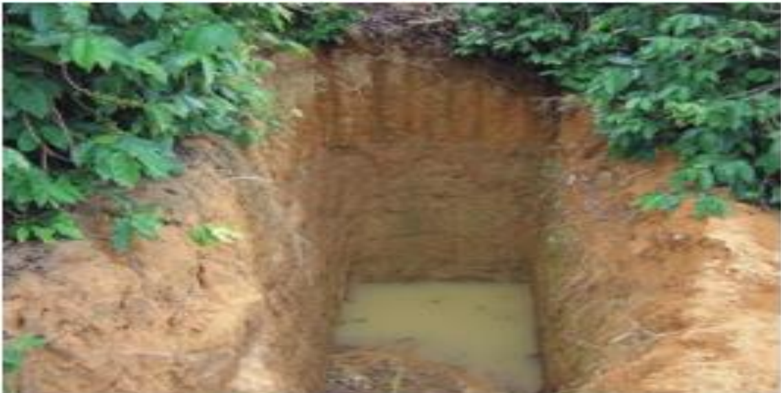
Figura 13. Caixa trapezoidal de captação de água ao longo de estrada de terra. Fonte: Acervo do Incaper (2018).
