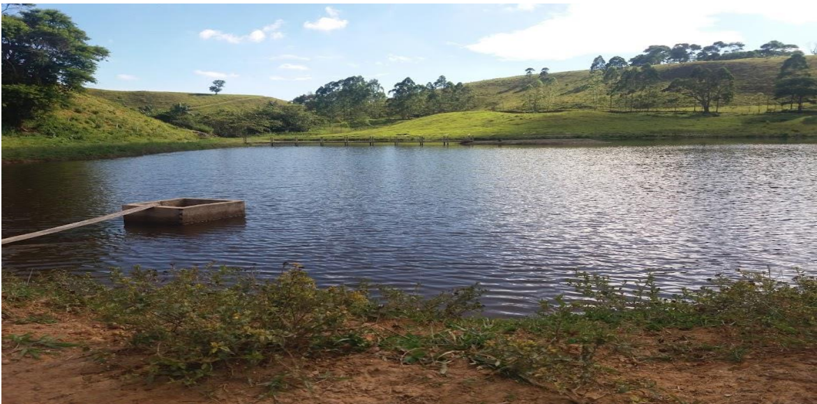
Figura 5. Barragem de terra com monge em alvenaria. Fonte: Acervo Priscila de Oliveira Nascimento (2018).
