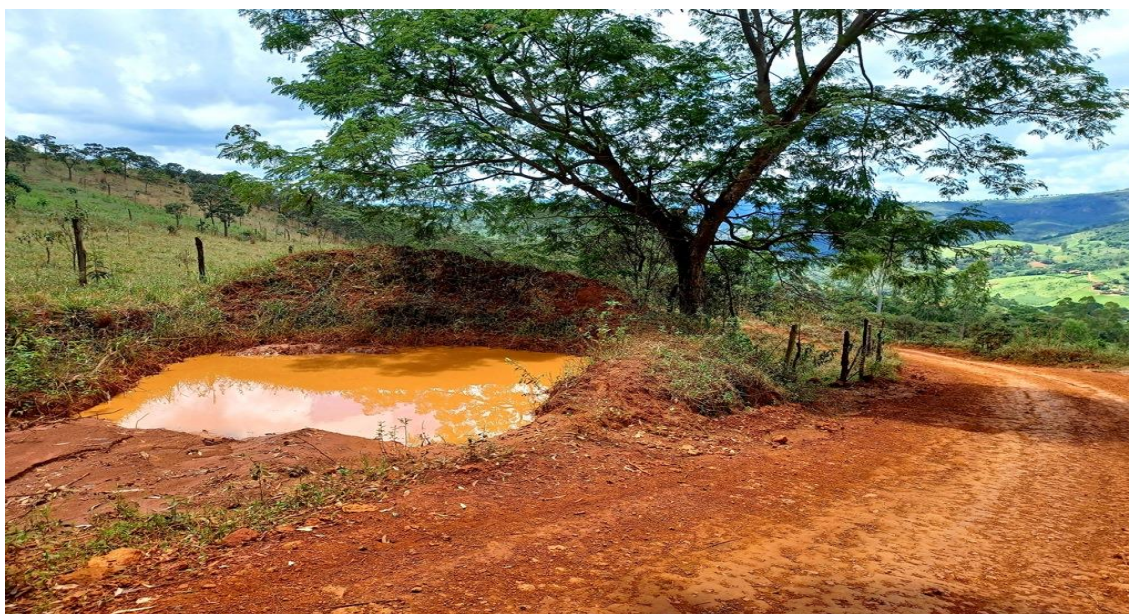
Figura 14. Barragem com sistema de drenagem para eliminar o excesso de água em Conceição do Mato Dentro, MG. Fonte: Acervo Maurício Novaes (2022).
